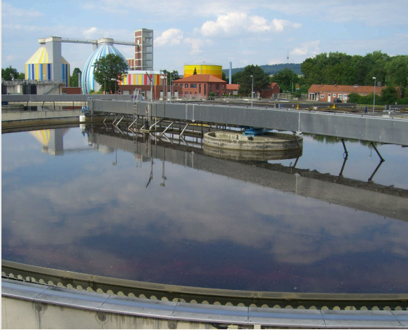
Очистные сооружения: вторичный отстойник с башнями
